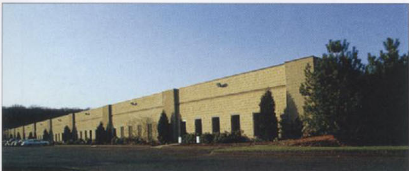
미국 코네티컷주 Branford에 있는 PANTAK 공장 및 사무실
